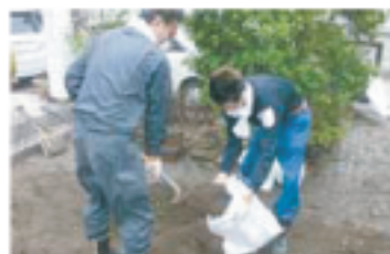
▲民家の泥かき作業
