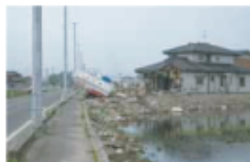
▲多賀城市の被災現場
